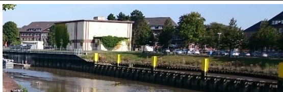
Taktikzentrum der Marine in Geestemünde Nord (Elbestraße)
