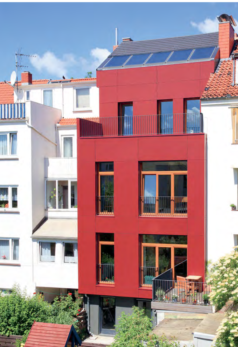
Durch die energetische Modernisierung dieses Altbremer Hauses in der Meyerstraße konnte der Primärenergiebedarf für Heizung (incl. Raumlüftung) und Warmwasser um rund 90 Prozent gesenkt werden.
