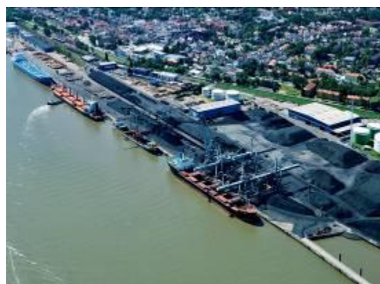
Abb. 5 - 6 Hafen Nordenham (Niedersachsen Ports)
